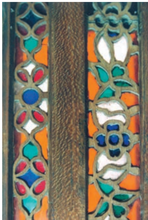
تصویر ۳-۱-۱- پارچه‌بری نصب شده در کنارهٔ یک در
