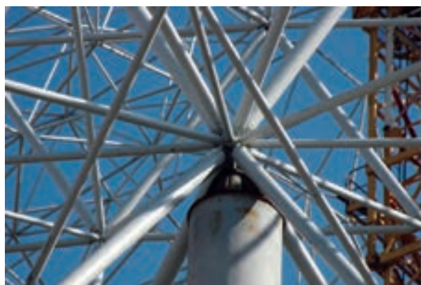
شکل ۲۰-۱۰- نمونه‌ی اتصال اعضای خرپای فضاکار
