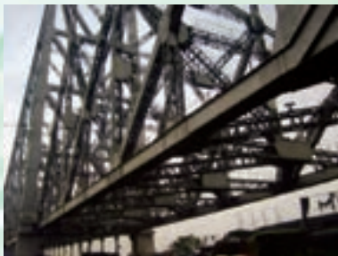
کاربرد المان خربایی در سازه پل فولادی
