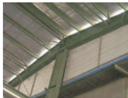
شکل ۱۰-۳۱- اجرای مهاربند افقی در قاب شیب دار
