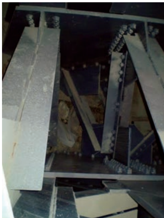
شکل ۱۰-۶ - اتصال پیچ و مهره‌ای اعضای خرپاها
