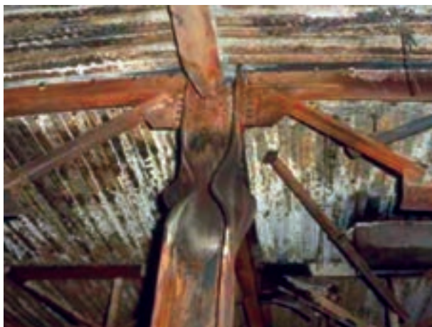
شکل ۴-۵- کمانش موضعی ستون
