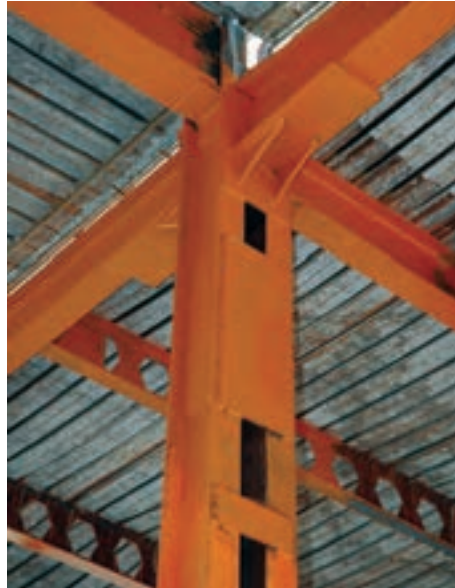
شکل ۴-۲۱- اتصال تیر به ستون دابل پا باز
