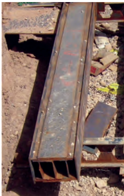
شکل ۴-۱۸- مقطع مرکب سه‌تایی با ورق تقویتی
