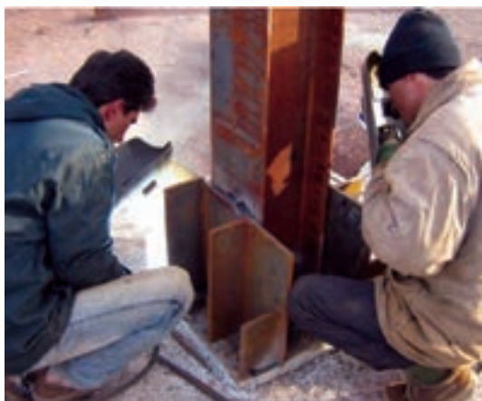
شکل ۴-۲۶- جوشکاری کامل پای ستون و ملمقات آن
