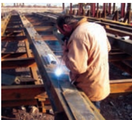
شکل ۴-۱۵- جوشکاری ستون جفت (وی شاسی کار)
