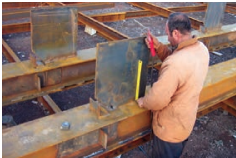
شکل ۴-۲۲- نصب ملمقات ستون روی شاسی‌های مونتاژ
