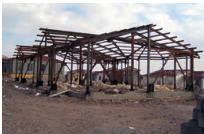
شکل ۴-۲- نمونه اسکلت فولادی شامل اعضای فشاری
