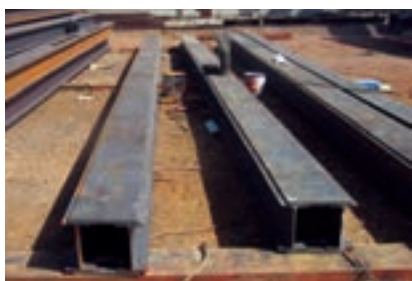
شکل ۴-۱۶- ستون دابل با ورق تقویتی یکسره
