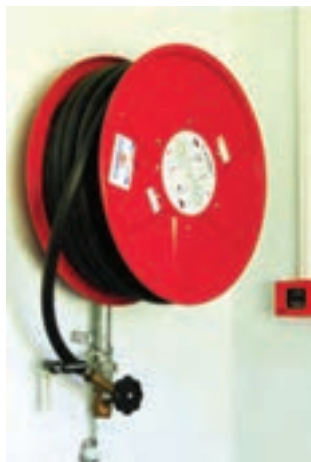
شکل ۴-۲- یک نمونه شیلنگ قرقره آب تحت فشار
