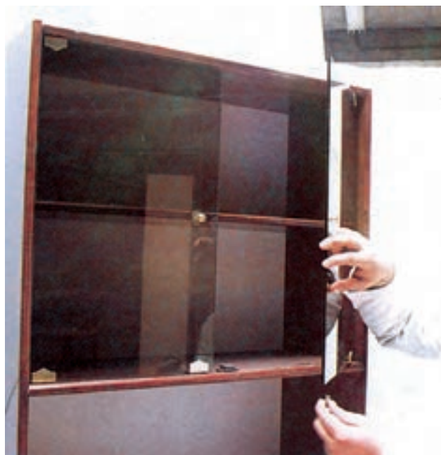
شکل ۱۱-۱۳- نحوه نصب اتصال مخصوص آهن‌ربا
