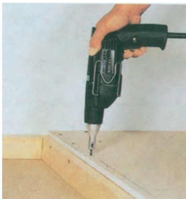
شکل ۱۲-۱۲- نحوه‌ی کاربرد دریل پیچ‌گوشتی برقی دستی ساده
