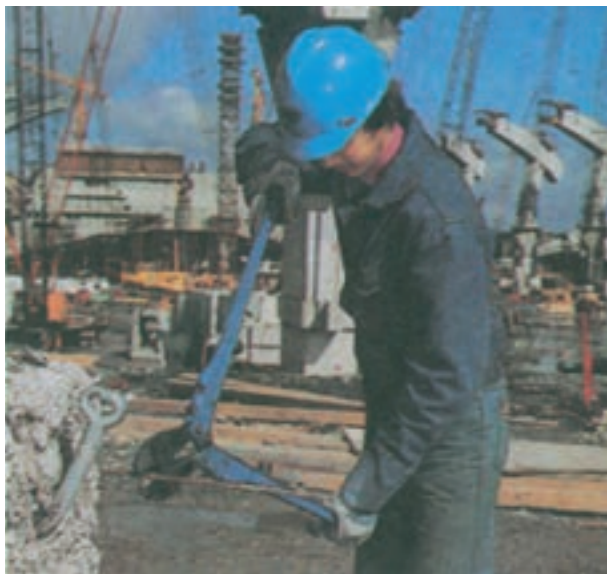
شکل ۱۲-۵۲- نحوه‌ی کاربرد سیم‌چین بزرگ
