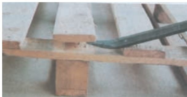
شکل ۱۱-۱۵- نحوه‌ی خارج کردن سر میخ
