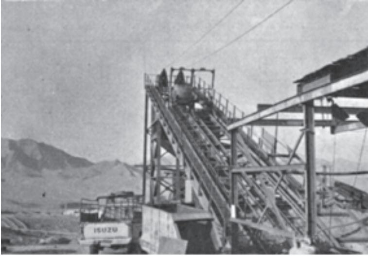
شکل ۱۲-۲۶- تخلیه و آگون‌ها در معدن کوشک
