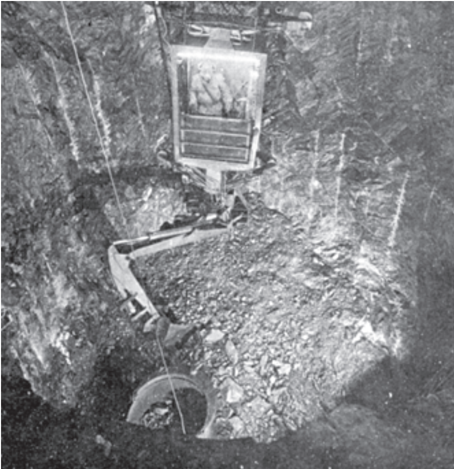
شکل ۱۰-۱۲- بارکننده قاشقی در چاه
