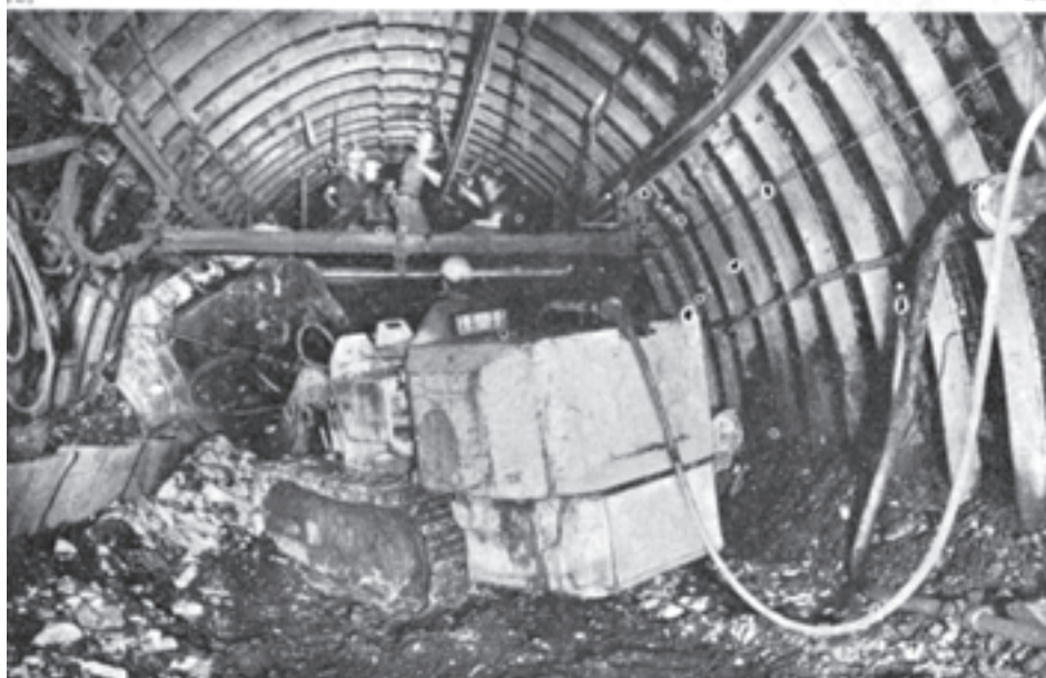
شکل ۱۰-۳ نحوه کار بارکننده در تونل
