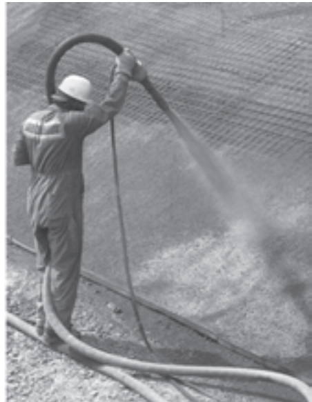
شکل ۷-۳۲- ایجاد یک لایه بتن با سیستم شاتکریت
