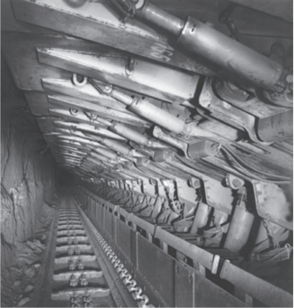
شکل ۹-۱۹- پایه قدرتی در کارگاه استخراج
