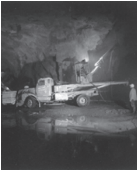
شکل ۷-۳۲- ایجاد یک لایه بتن با سیستم شاتکریت
