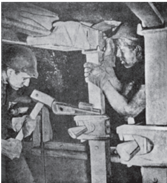
شکل ۹-۸ - نحوه نصب پایه‌های فلزی
