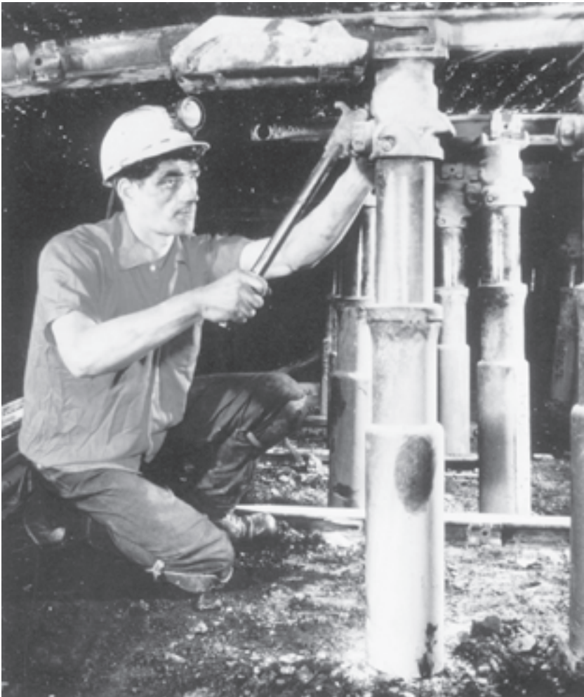
شکل ۹-۱۰- نصب پایه‌های هیدرولیکی در کارگاه استخراج
