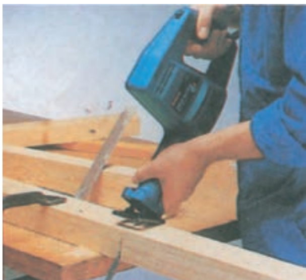
شکل ۲-۵۹- برش تیرها به وسیله‌ی اره‌ی چکشی افقی بُر (همه‌کاره)
