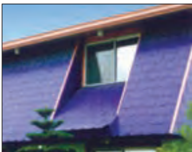
شکل ۴۷-۱ پوشش نهایی سقف شیب‌دار با آردواز
