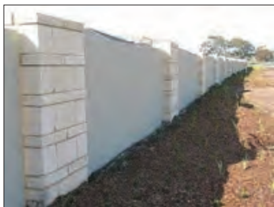
شکل ۱-۱۳۲ دیوار با ترکیب مصالح سنگ و قطعات پیش ساخته‌ی بتّنی
