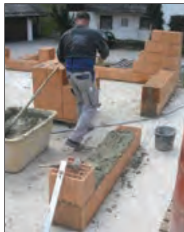
شکل ۱-۱۵۳ ساخت دیوار با بلوک سفالی
