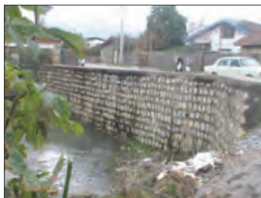
شکل ۱-۱۱۰ دیوار حائل سنگی
