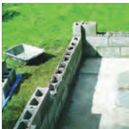
شکل ۱۵۰- ساخت دیوار با بلوک‌های بتنی یا سیمانی
