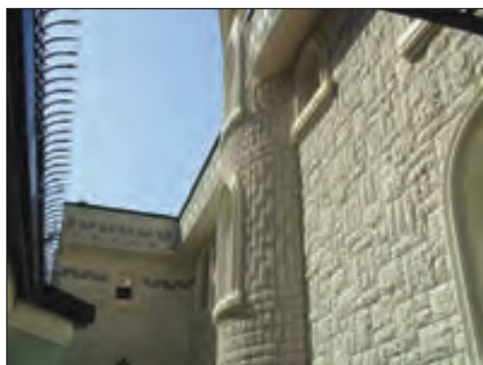
شکل ۱-۱۳۱ دیوار با مصالح سنگ بادبُر
