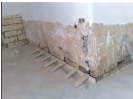
شکل ۱-۹۰ اندود گچ و خاک - گچ سفید پرداختی
