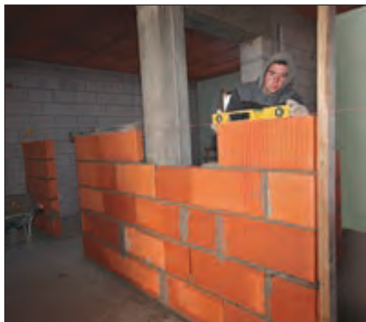
شکل ۱-۱۰۹ دیوار غیرباربر بلوک سفالی
