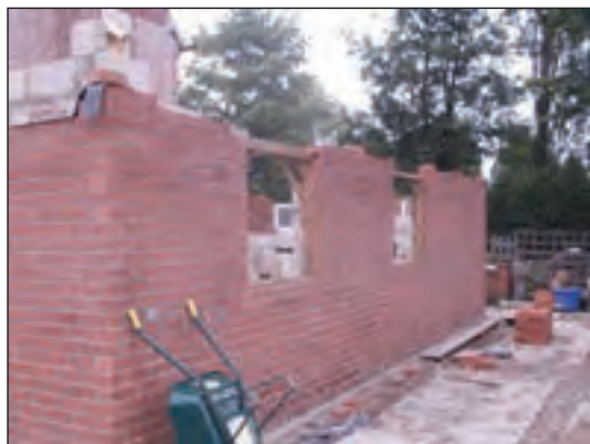
شکل ۱-۱۰۷ دیوار باربر آجری
