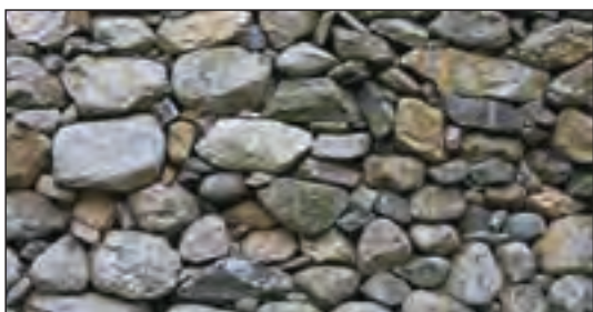
شکل ۱۳۶- دیوار سنگی خشکه چین
