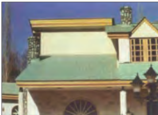
شکل ۱-۱۰۲ پوشش سقف با ورق‌های فشرده‌ی آردواز
