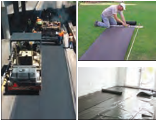
شکل ۴۴-۱ کاربرد قیر در آسفالت کاری و ایزوگام
