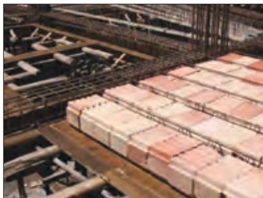
شکل ۱-۱۵۲ کاربرد بلوک سفالی در سقف
