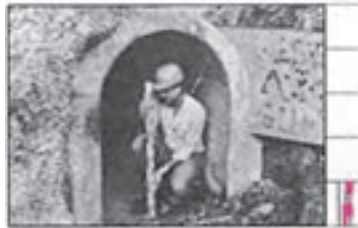
شکل ۱۴-۸- طریقه‌ی نگاه داشتن میر
