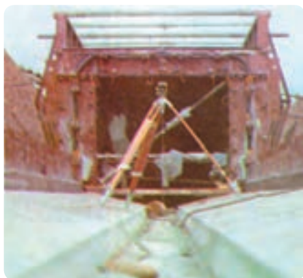
شکل ۳۰-۸- دوربین تراز یاب، سانتراژ با شاقول
