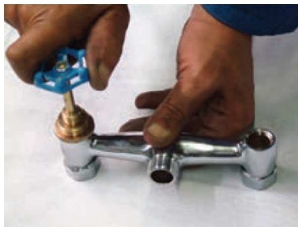
ج) عمل کف تراشی شیر
