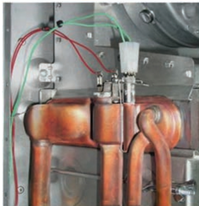
شکل ۱۶-۱۴- موقعیت سنسور دمای آب رفت به رادیاتور
