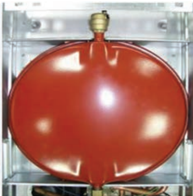
شکل ۲۲-۱۴- شیر هواگیری اتوماتیک
