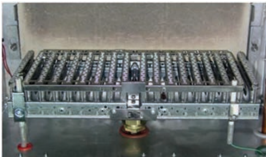
شکل ۱۲-۱۴- الکتروود یون در مشعل
