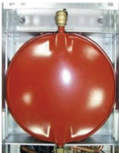
شکل ۱۴-۲۱ مخزن انبساط با شیر هواگیری
