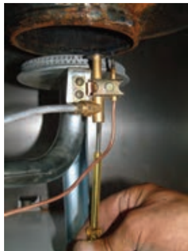
شکل ۶-۱ تنظیم شعله پیلوت
