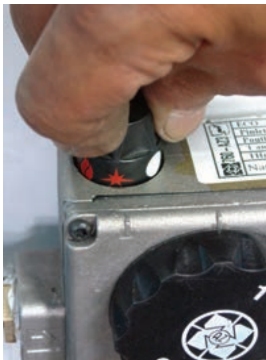
شکل ۷-۱۲- فشار شستی برای خروج گاز
