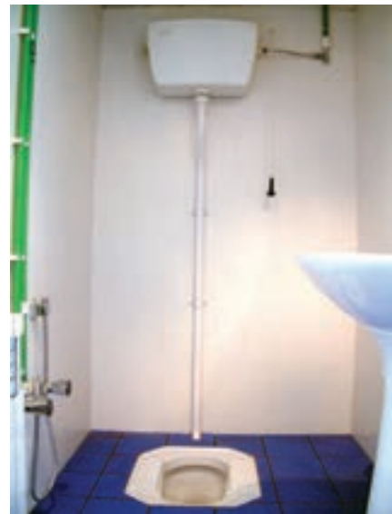
شکل ۳۳-۱۰- اتصال مخزن فشاری به کاسه توالت ایرانی
