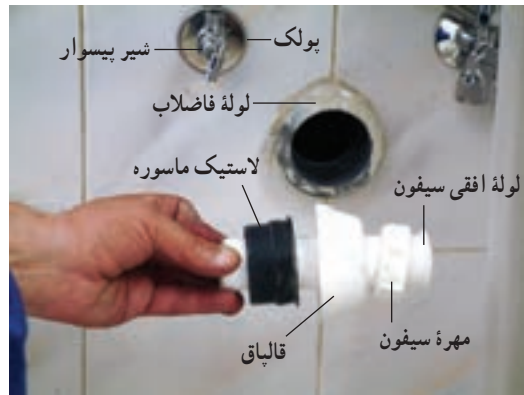
۲- عبور دادن لوله سیفون افقی از درون مهره سیفون، قالباق و لاستیک ماسوره
