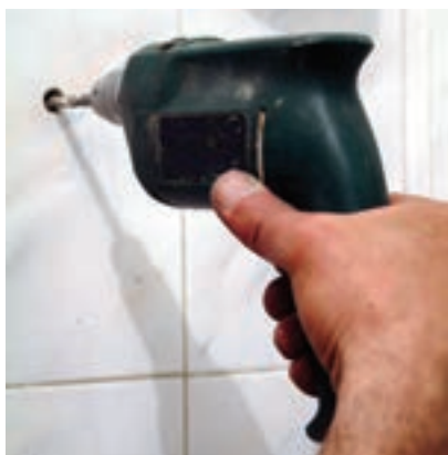
۲- سوراخ کردن محل پیچ‌های روکا
