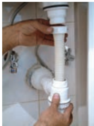
۵- بستن مهره لوله سیفون عمودی به انتهای زیراب
