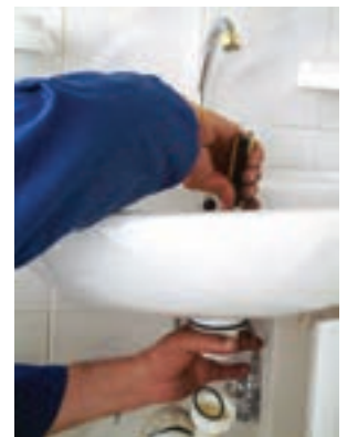
۱- بستن زیراب دست شویی به وسیله پیچ گونشتی
