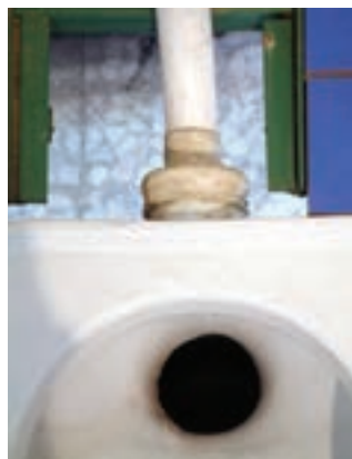
(الف) اتصال لوله تخلیه و رابط لاستیکی به مجرای ورودی کاسه توالت
