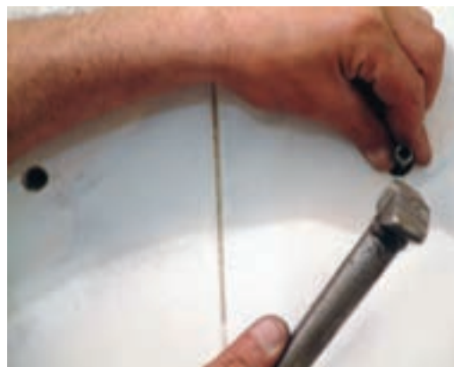
۳- کوبیدن رول پلاک در درون سوراخ‌ها
