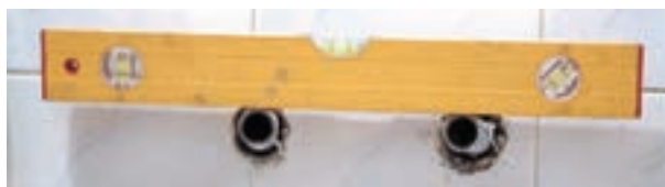
۷- سنجش صاف بودن دنباله‌ها به وسیله تراز
