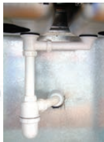
(الف) اتصال ظرف شویی دو لگنه به لوله فاضلاب
