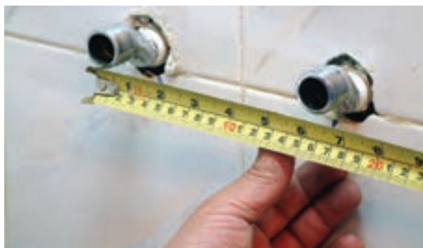
۶- کنترل اندازه وسط تا وسط دنباله‌ها به وسیله متر
