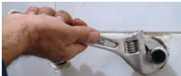
۵- سفت کردن دنباله‌ها با آچار فرانسه
