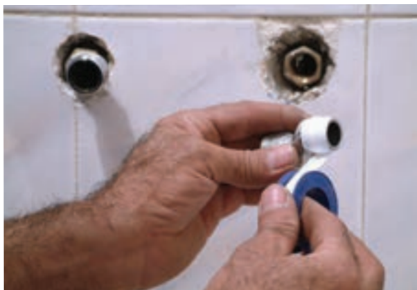
۳- پیچیدن نوار تفلون بر روی دنده \frac{1}{2} " دنباله شیر شکل ۶-۱۰
