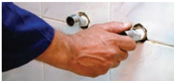
۴- بستن دنباله‌ها با دست به دهانه لوله‌های آب سرد و آب گرم
