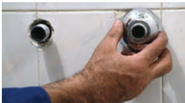
۸- بستن کاسه‌ها (قالب‌ها) به دنده \frac{3}{4} " دنباله‌ها با دست
