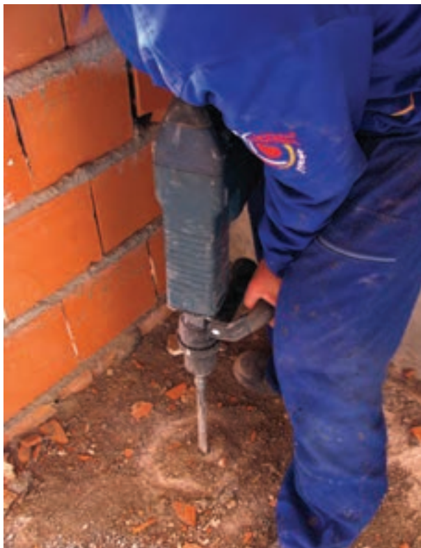
شکل ۴-۸ - سوراخ‌کاری برای عبور لوله فاضلاب
