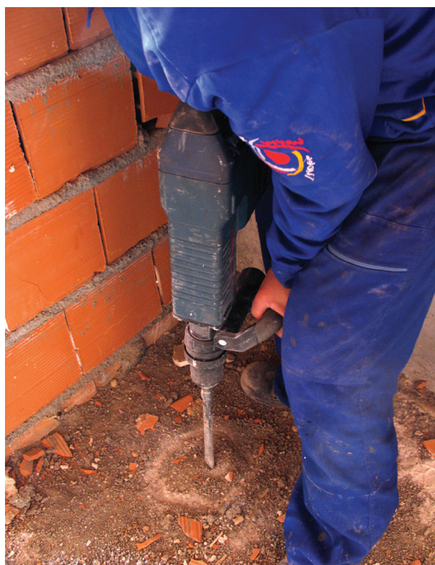
شکل ۴-۸ - سوراخ‌کاری برای عبور لوله فاضلاب
