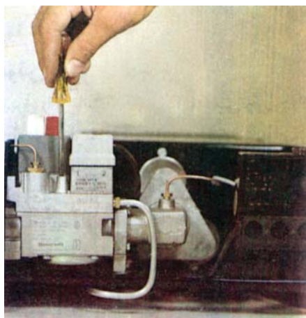
شکل ۳۲-۵ - تنظیم شعله پیلوت
