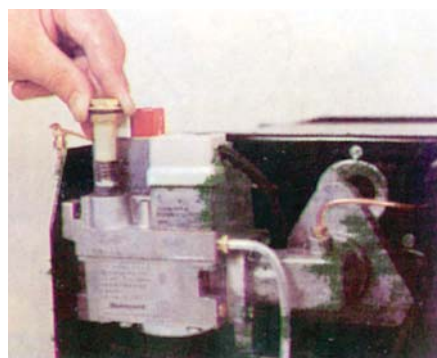
شکل ۳۷- ۵- تعویض بوبین
