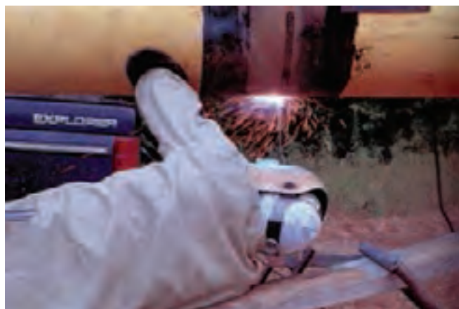
شکل ۴۶-۷- جوش کاری SMAW در لوله که بالای سر انجام می‌شود، وضعیت جوش کاری "5G" می‌باشد.
