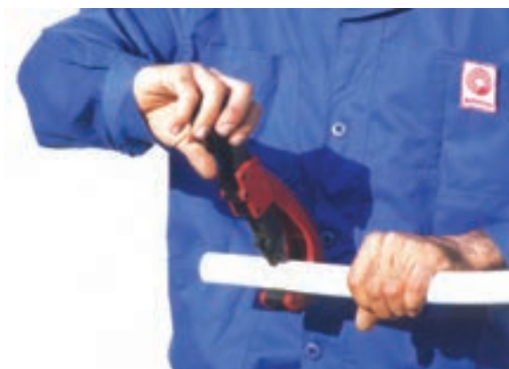
شکل ۳-۴- لوله بر و نحوه کار با آن
