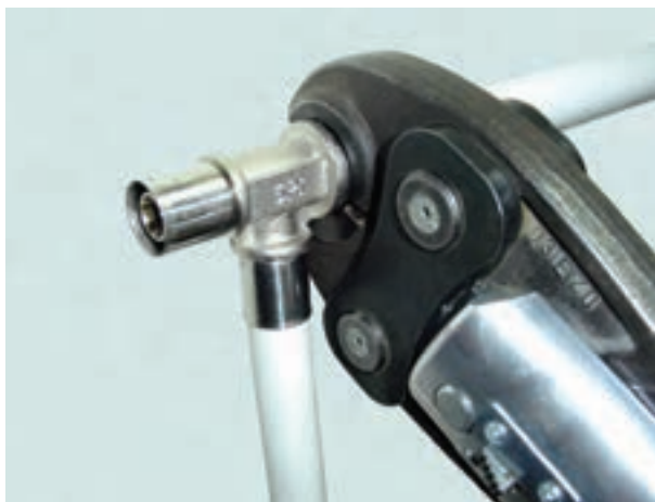
شکل ۱۱-۴- نحوه کار با دستگاه پرس
