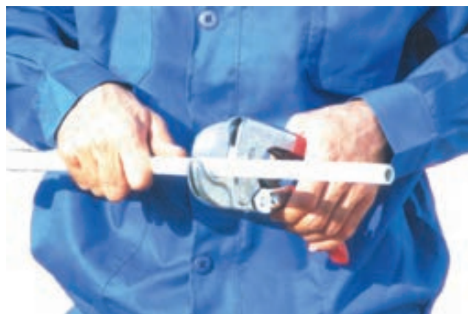
شکل ۲-۴- بریدن لوله با قیچی
