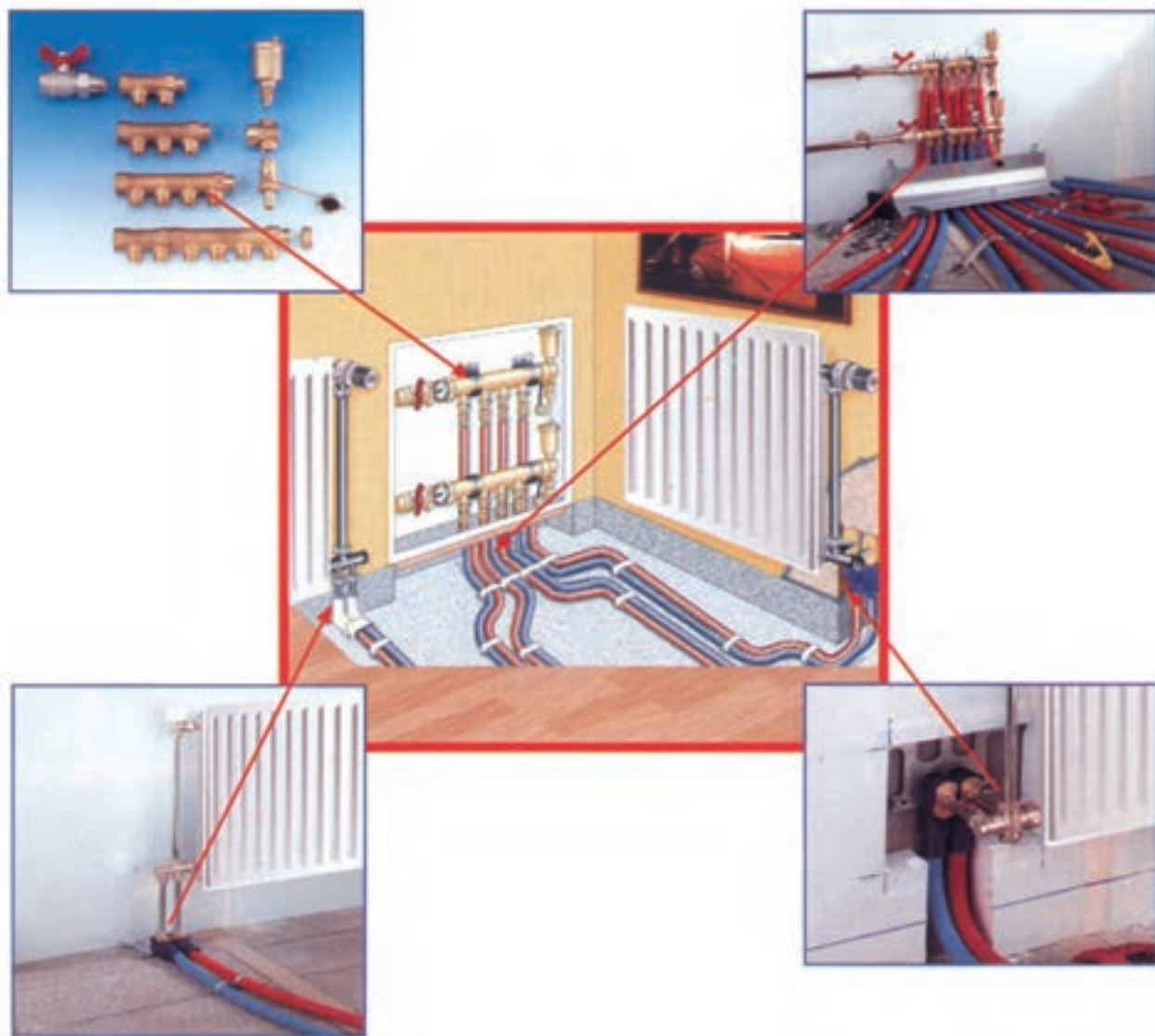
شکل ۱-۳- لوله کشی حرارت مرکزی با استفاده از لوله و فیتینگ تک لایه PEX
