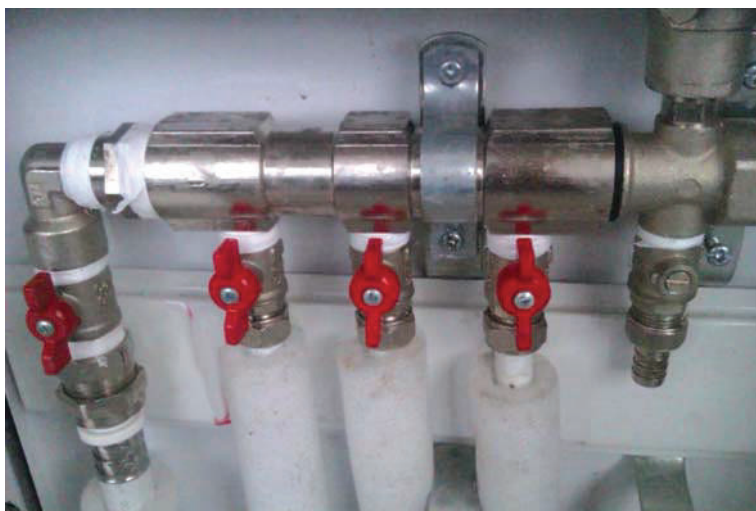
شکل ۱۹-۳- اتصال سرلوله‌ها به کلکتور
