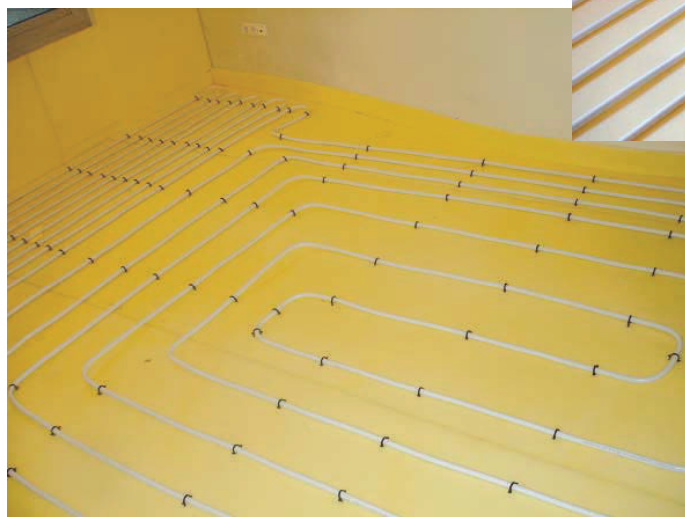
شکل ۳-۱۸- کف گرمایی اجرا شده
