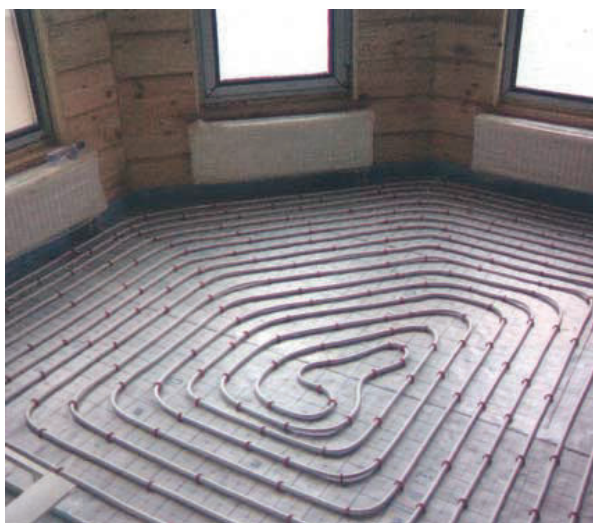
شکل ۹-۳- نمایش سیستم گرمایش از کف
