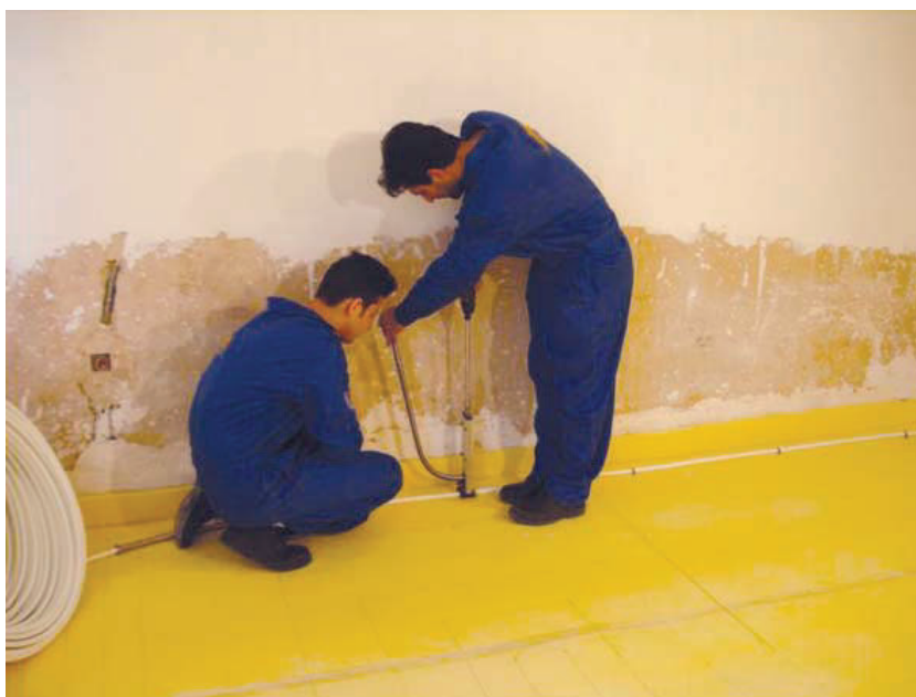
شکل ۳-۱۶- بست زدن لوله‌ها
