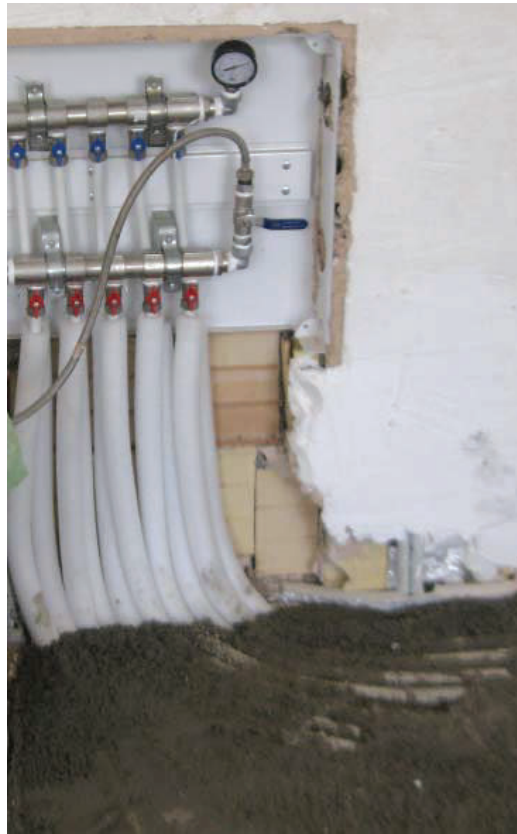
شکل ۳-۲۱- پوشاندن لوله ها
