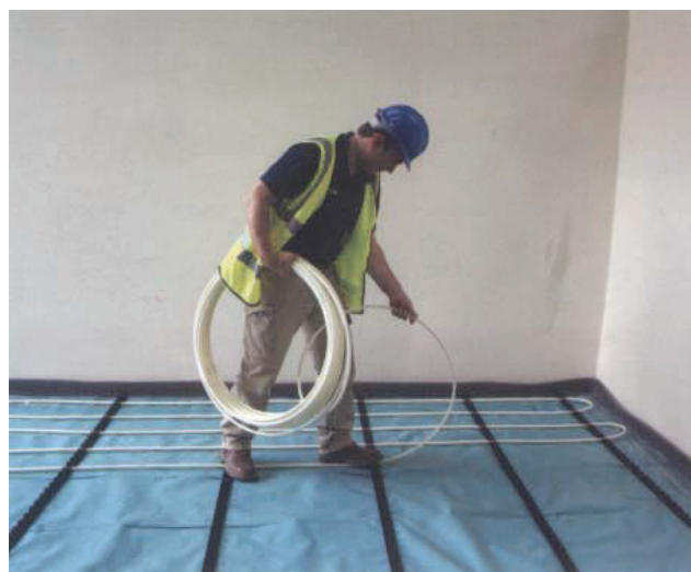
شکل ۹-۳- نمایش سیستم گرمایش از کف
