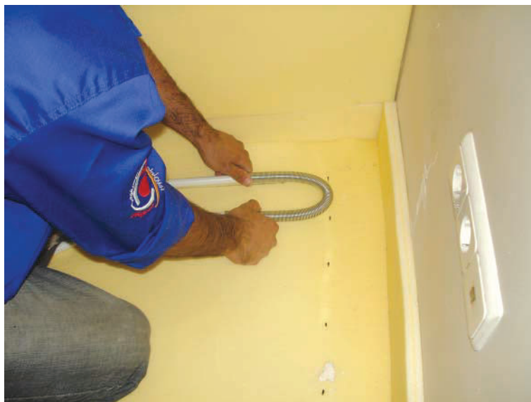
شکل ۳-۱۷- چگونگی خم کردن لوله
