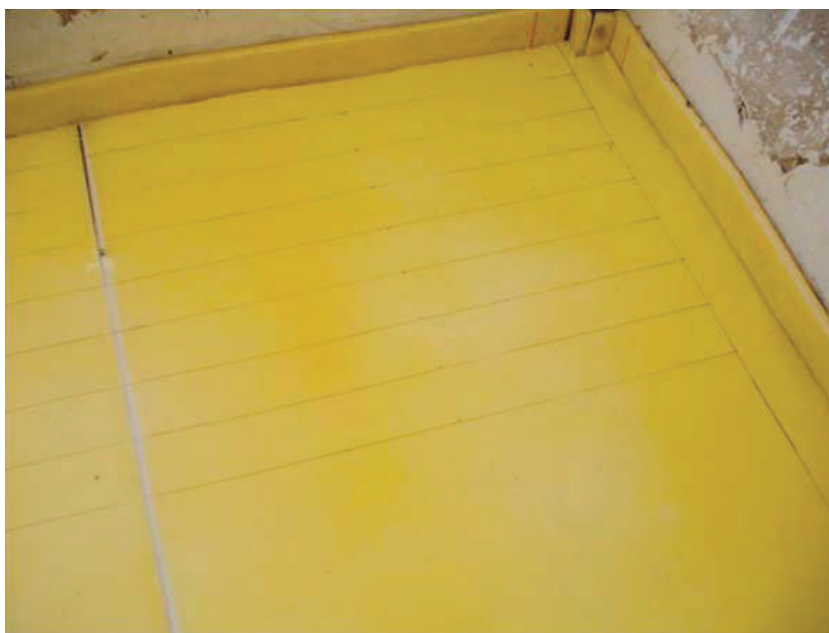
شکل ۳-۱۴- پیاده کردن نقشه روی کف
