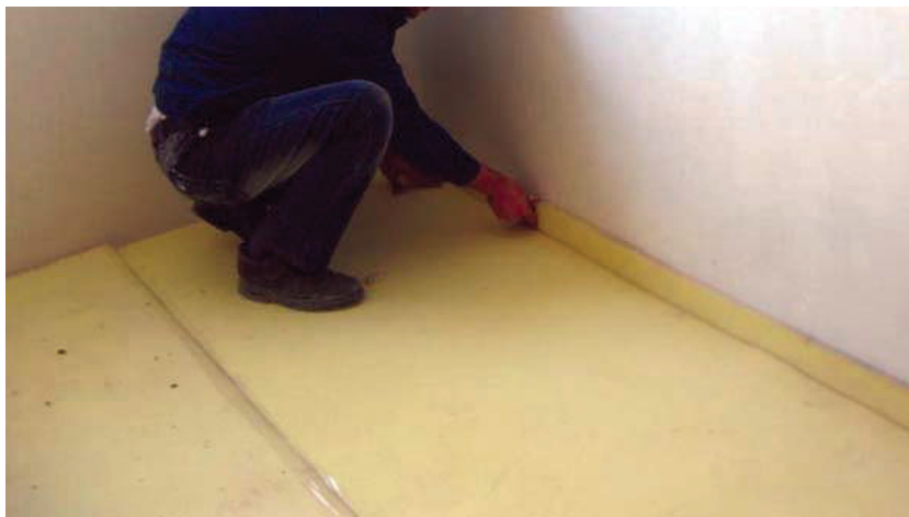
شکل ۳-۱۳- عایق کاری پیرامونی
