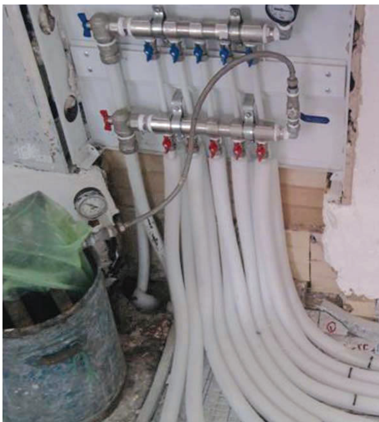
شکل ۲۰-۳- آزمایش آب‌بندی لوله‌کشی
