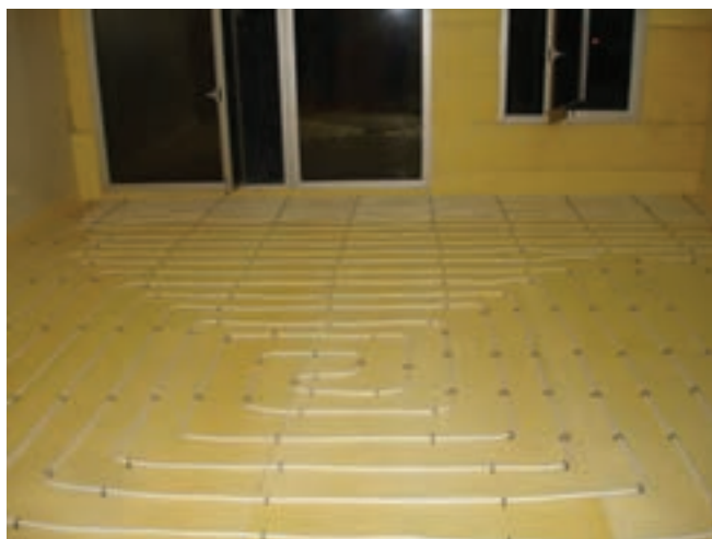
شکل ۱۸-۴- اجرای سیستم کف گرمایی در یک اتاق
