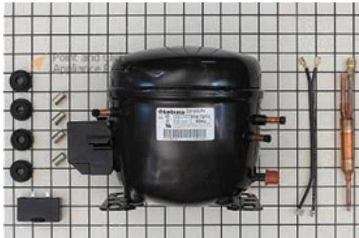
شکل ۲-۵— تصویر یک کمپرسور بسته‌ی تناوبی (هرمتیک) ۱
