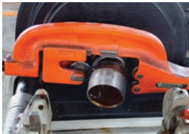
شکل ۳۹-۱- عمل بریدن لوله
