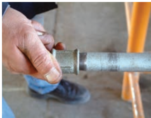
شکل ۳۶-۱- آزمایش دنده
