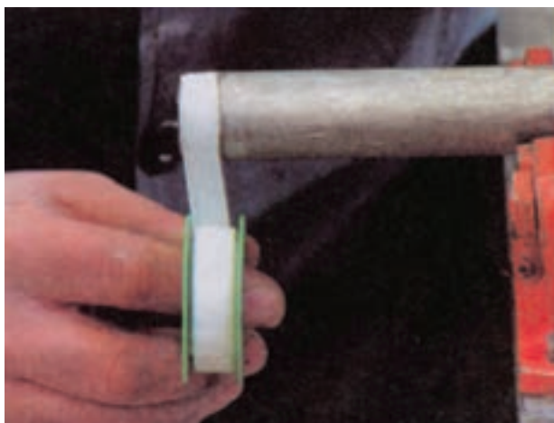
شکل ۵۳-۱- پیچیدن نوار تفلون به سر لوله
