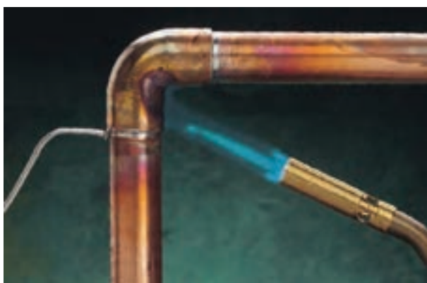
شکل ۱-۴۲- مراحل اتصال لوله‌ی مسی با فیتینگ‌های لحیمی
