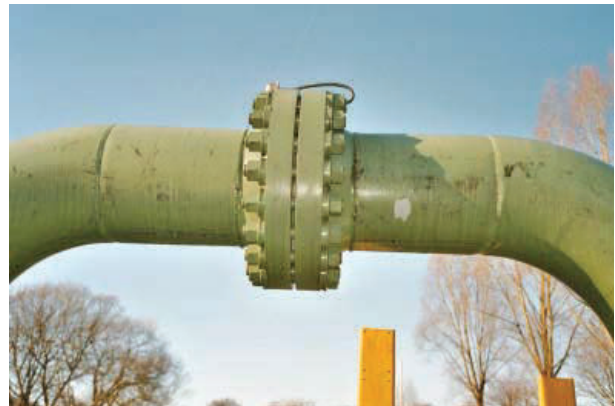
شکل ۱-۲ اتصال با فلنج
