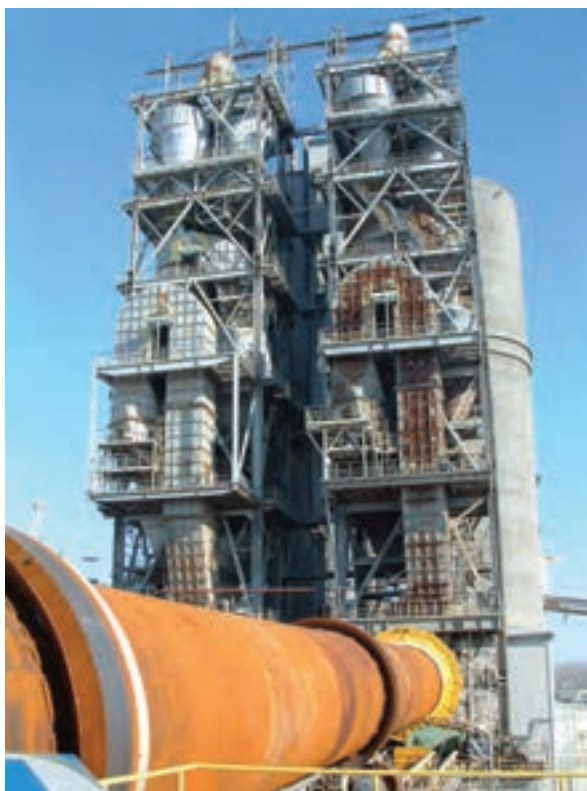
شکل ۲-۹- نمایی از کارخانه‌ی سیمان
