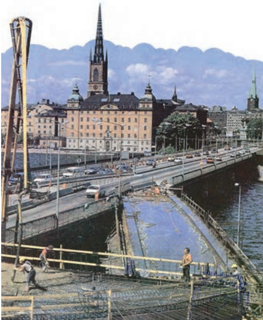
شکل ۶-۷- بتن آماده، در حال تخلیه به وسیله پمپ نصب شده بر روی کامیون
