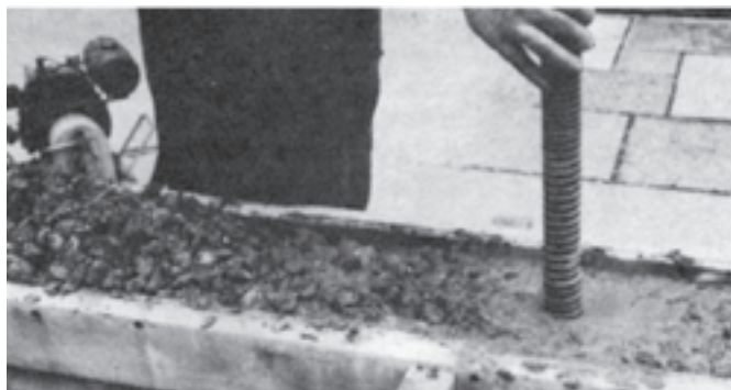
شکل ۱۳-۶- در نقاطی که بلافاصله نزدیک میله قرار گرفته‌اند، بتن کاملاً متراکم شده است. باید دقت کرد که سطح بتن در این نقاط چگونه پایین رفته است.
