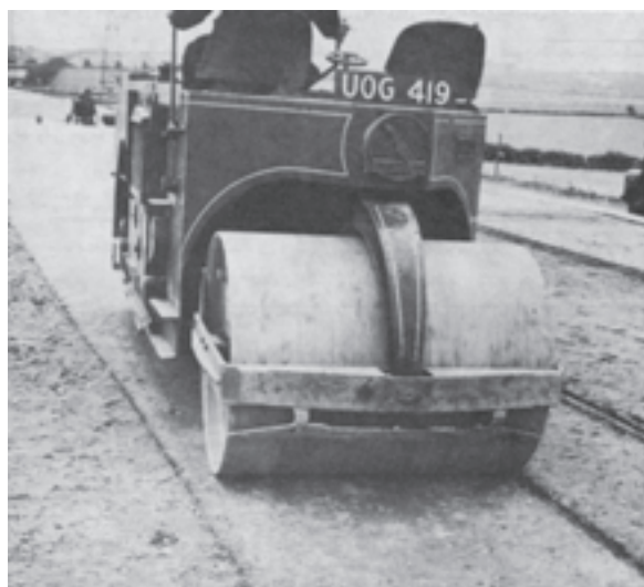
شکل ۶-۹- متراکم کردن بتن کم‌عیار با غلتک
