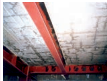
دال مرکب بتنی پس از بتن‌ریزی
