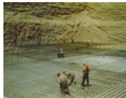
نمایی از یک فونداسیون گسترده (رادیه) مربوط به یک مجتمع مسکونی ۲۰ طبقه در حال آرماتوربندی
