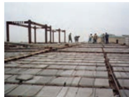
قرار دادن آرما توری بر روی بلوک‌های سقف تیرچه بلوک برای جلوگیری از پدید آمدن ترک‌های عمیق در سطح بتن
