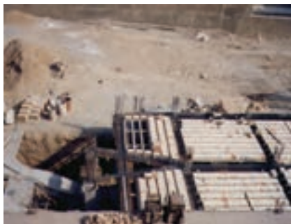
اجرای سقف تیرچه بلوک
