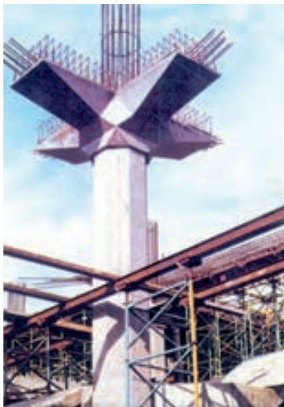
سازه‌ی بتنی از بتن سفید در حرم مطهر حضرت معصومه (س)
