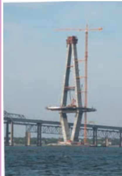
پایه‌ی بتنی یک پل کابلی
