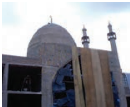
مسجد جامع شهر بم که پس از زلزله کاملاً سالم مانده است. اسکلت این بنا بتنی است.
