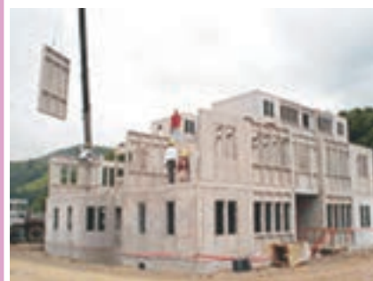
اجرای ساختمان پیش‌ساخته بتنی
