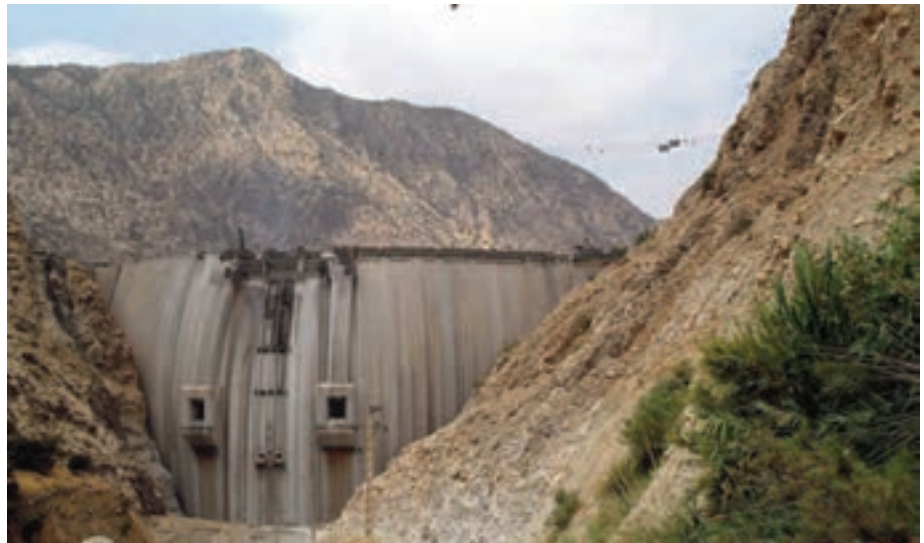
شکل ۱-۲- سد بتنی دو قوسی کارون ۳ که مرتفع ترین سد بتنی خاورمیانه است.
