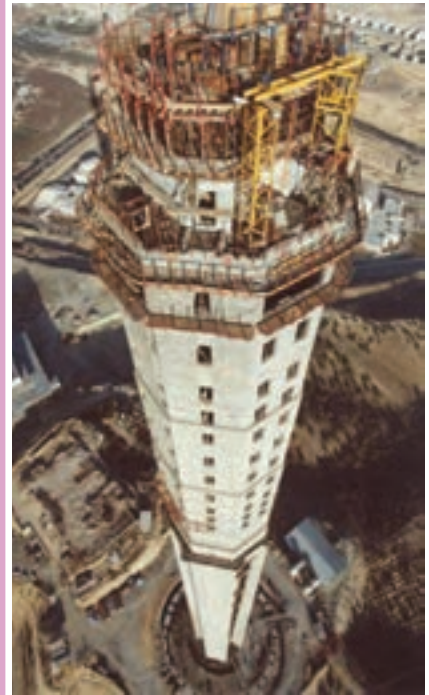
برج مخابراتی میلاد در حال ساخت
