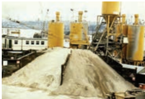
شکل ۱-۸ - استفاده از دیوار جداکننده در نگهداری سنگ‌دانه‌ها
