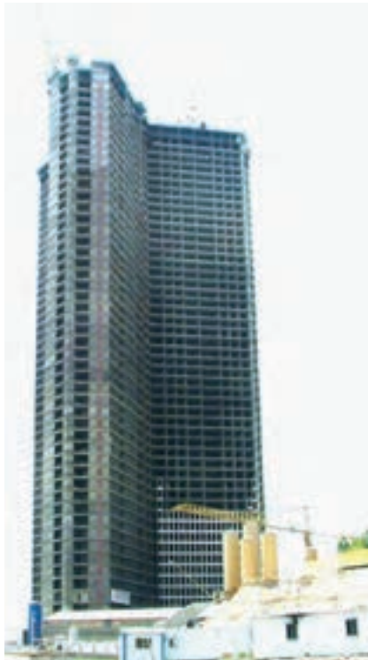
ساختمان بتنی با پلان Y شکل، برج تهران
