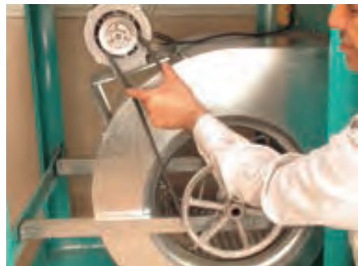
الف- طرز قرار گرفتن تسمه روی پولی‌ها
