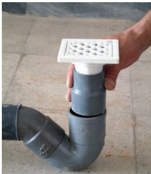
شکل ۳-۱۹- اتصال کف شوی به وسیله ی تبدیل
