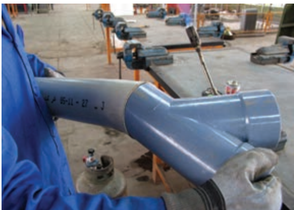
شکل ۲-۹- درست کردن سرکاسه
