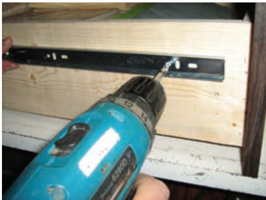
شکل ۷-۳۶ نصب ریل بر روی بدنه‌ی کشو
