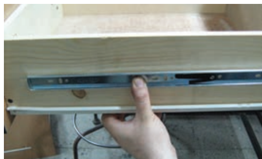
شکل ۷-۳۵ تعیین محل ریل بر روی بدنه کشو
