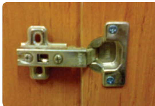
شکل ۸۵-۶ نصب کاسه لولا روی در کابینت
