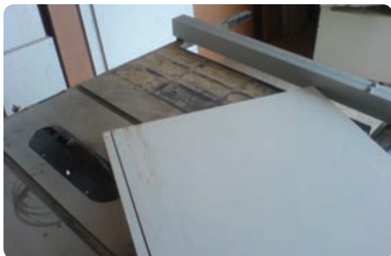
شکل ۶-۶۹- کنشکاف زدن جهت پشت بند
