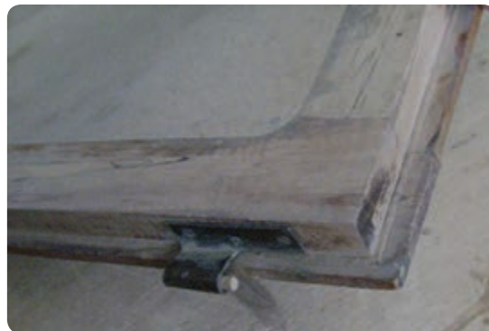
شکل ۹۱-۶ نصب لولای قابل‌همه‌ای در دو راهه در
