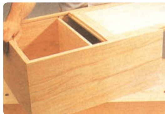
شکل ۱۴۳-۶ قرارگیری پشت بند در کنشکاف بدنه کابینت
