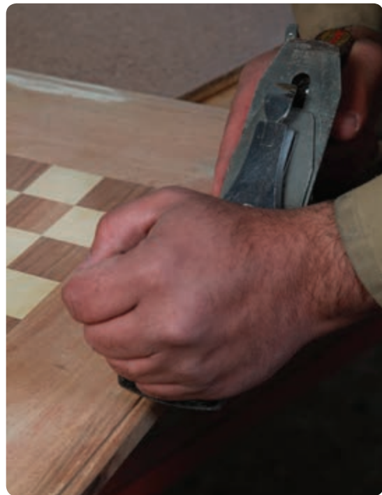
شکل ۷۹-۶ رنده کردن زهوار چوبی
