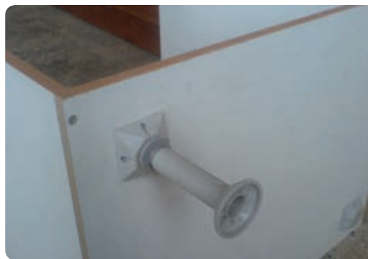
شکل ۶-۱۱۵ پایه نصب شده زیر کابینت
