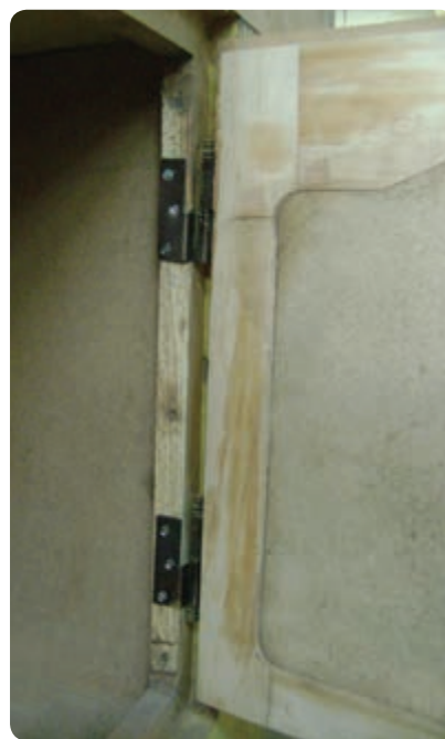
شکل ۶-۸۸ در قاب تنکه‌ای با لولای قابل‌مهای
