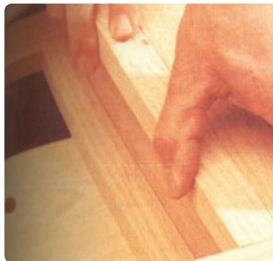
شکل ۶-۱۵۶ نصب ریل هدایت کشو
