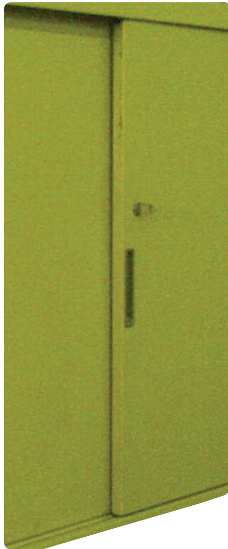
شکل ۶-۳۰-۱: در کشویی با دستگیره توکار
