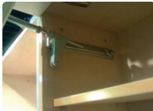
شکل ۶-۳۷ در کابینت نصب شده با نگهدارنده پمپی
