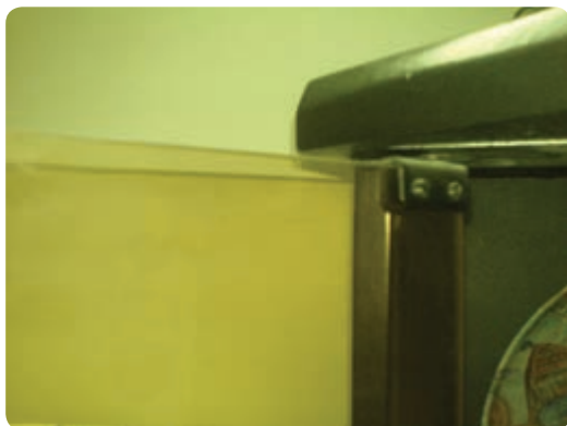
شکل ۶-۴۰ در شیشه ای با لولای پاشنه ای
