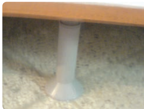
شکل ۶-۶۴ پایه نصب شده در زیر کابینت
