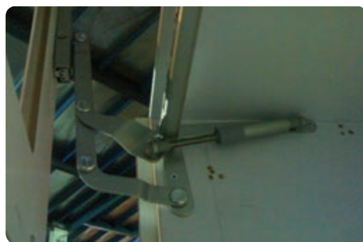
شکل ۶-۳۸ در کابینت نصب شده با جک اتوبوسی
