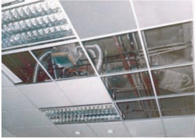
تصویر ۲۰ - زیر سازی سقف کاذب
