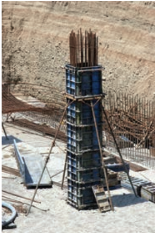
تصویر ۴ - قالب‌بندی فلزی ستون
