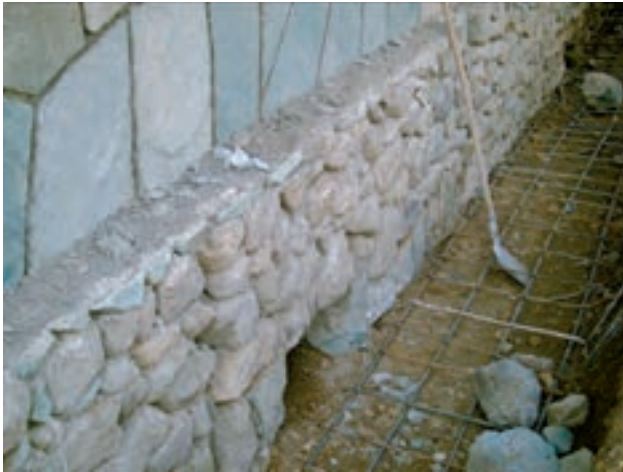
تصویر ۱- پی و دیوار سنگی
