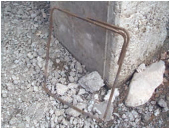
تصویر ۷ - نمونه‌ی یک خاموت
