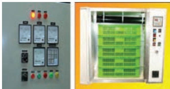
شکل ۴۴-۵- کاربرد لامپ‌های سیگنال در دستگاه جوجه‌کشی و تابلوی برق
