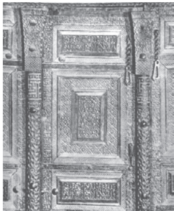
تصویر ۵-۲-۱- قسمتی از یک در - مربوط به مسجد بایزید بسطامی - قرن هشتم هجری، دارای قاب بندی، رویه کوبی و کنده کاری، دارای نقوش خط کوفی - هندسی - اسلیمی
