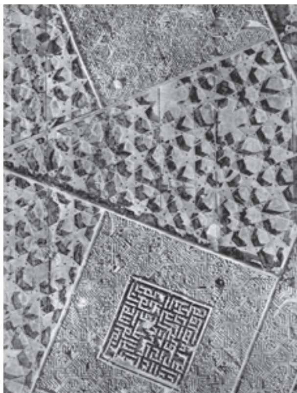
تصویر ۷-۲-۱- قسمتهایی از سقف مسجد جامع شیراز - احتمالاً قرن هفتم و هشتم هجری دارای رویه کوبی و زهوار کوبی با میخ نقش هندسی و خط بنایی
