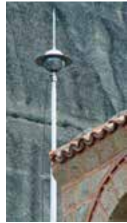
شکل ۲-۱۳ میله‌ی برق‌گیر به سیم مقاومی متصل است و می‌تواند در صورت برخورد آذرخش به آن جریان زیادی را به زمین هدایت کند.
