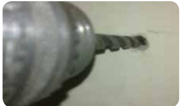
شکل ۶-۶ - سوراخکاری دیوار با مته الماسه مناسب
