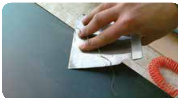
شکل ۲۵-۴ - نحوه برطرف کردن اضافه نوار با لیسسه
