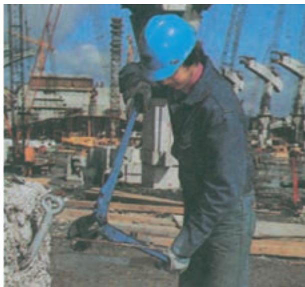
شکل ۱۲-۵۲- نحوه‌ی کاربرد سیم‌چین بزرگ
