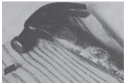
شکل ۷-۶۸ نحوه‌ی کوبیدن سوزن دوخت زیگزاگی در چوب
