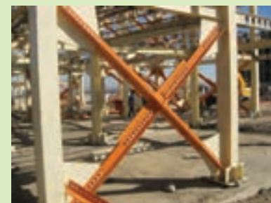
اجرای اتصال بادبندها از نوع پیچی
